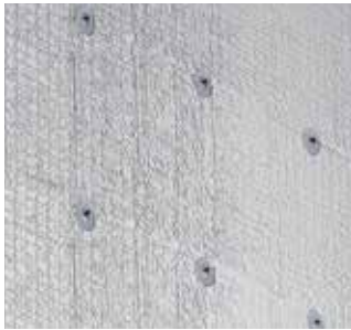
Disposition des chevilles de soudage
