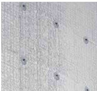
Opstelling van de laspennen
